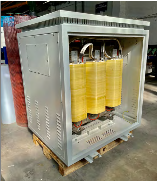
Trasformatore 500 KVA con processo VPI in Box IP21 RAL7035 500 KVA transformer with VPI process in IP21 RAL7035 Box
